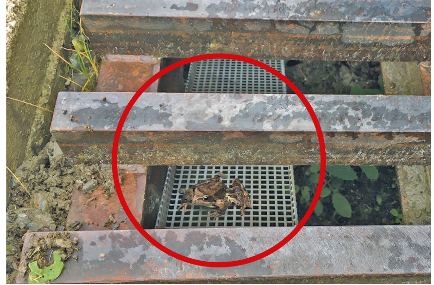
Das eingebaute Lochblech ermöglicht Amphibien und anderen Kleintieren den „Ausstieg“ aus der Viehsperrn. Foto: Willi Schwarzenbacher
