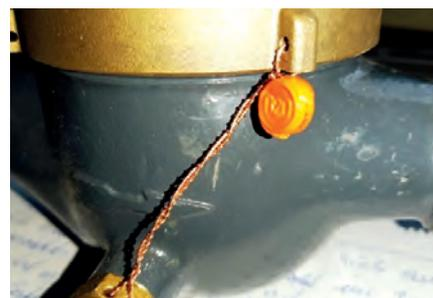
Sollte auf Grund von Umbauarbeiten an der Wasserleitung, der Wasserzähler ausgebaut werden, muss er nach dem Einbau wieder von mir verplombt werden.
