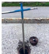
Das blaue Hinweisschild an der Hausmauer oder am Zaun zeigt die Bemalung des Hausanschlußschiebers an. Dieses Schild wird leider bei Arbeiten an der Fassade oder Erneuerung des Zaunes oft nicht mehr montiert. Bei einem Notfall im Winter ist der Schieber dann schwer zu orten.
