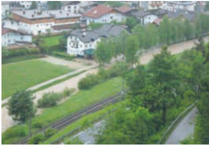
Blick von der Drehleiter zum Birkenweg, Bau- meister Heigl
